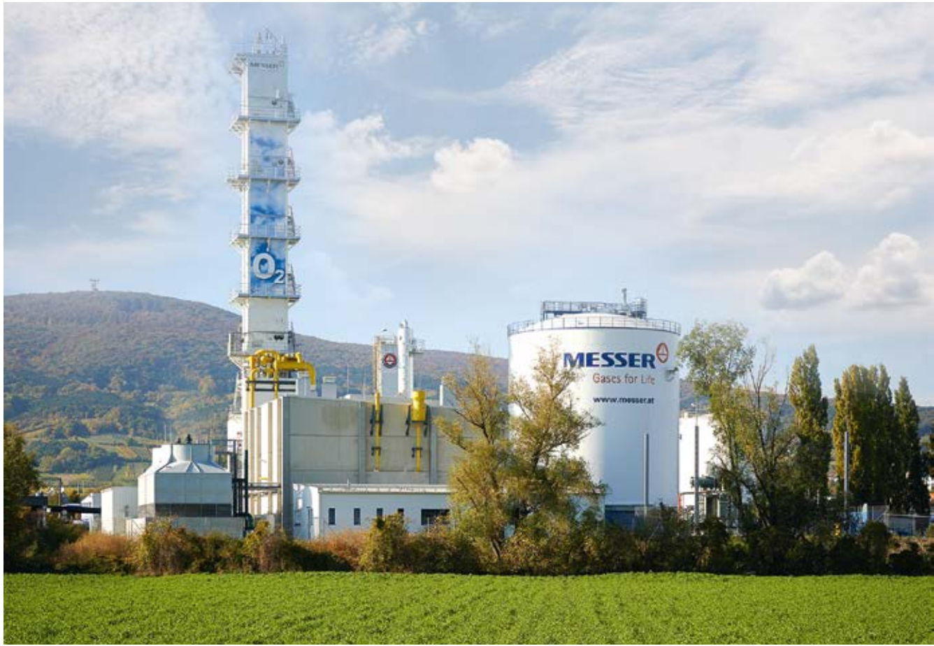
Luftzerlegungsanlagen verarbeiten ausschließlich Umgebungsluft zur Erzeugung von Industriegasen.
