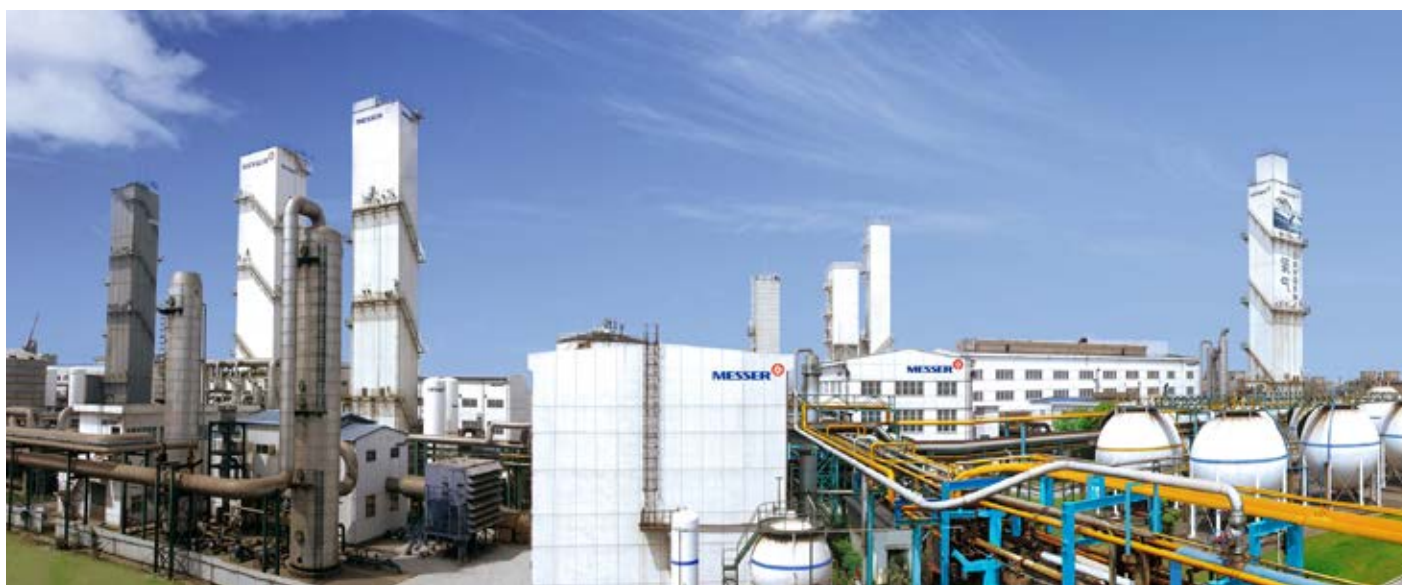
Messer ist Pionier im Industriegasemarkt von Hunan und hat bereits in insgesamt neun Luftzerlegungsanlagen investiert.
