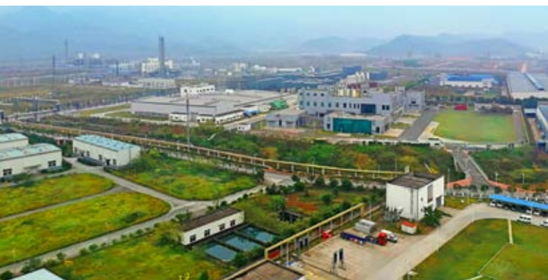
Seit Mitte 2017 beliefert der Industriegasespezialist Messer zwei neue Kunden im Chemiepark Changshou in Chongqing, China, per Pipeline mit Gasen
