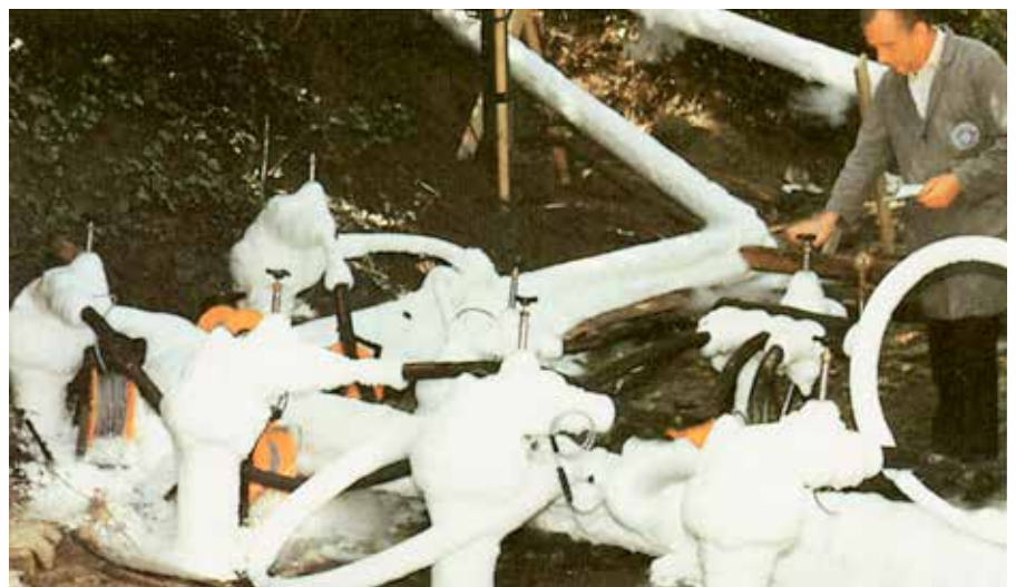
Über Gefrierlanzen wurde an der Stadtbahn-Baustelle in Gelsenkirchen flüssiger Stickstoff in das Erdreich eingebracht, um es für die Dauer der Reparaturarbeiten unter Tage zu verfestigen.
