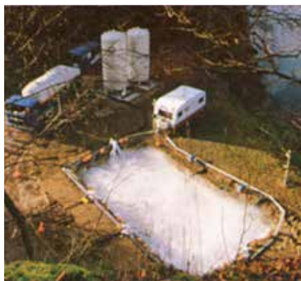
Gefrieren von Erdreich legt Baustelle trocken
