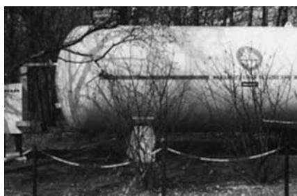
Ein Wasserstofftank versorgt die Bakterien in den Bioreaktoren.
